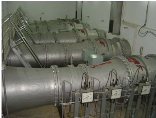
图1 量水间文丘里管的安装布局
